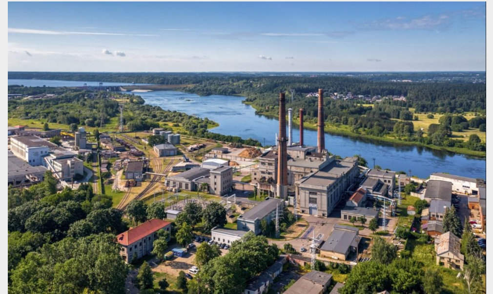
Petrašiūnai Power Plant, Kaunas
